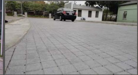
有一種在通氣導管塑膠框架上打上混凝土的高承載結構型透水鋪面（JW工法），其表層綿密的通氣管連通充滿粗骨材的基層空隙空間具有絕佳的透氣、透水保水與蓄洪功能。此種透水工法依其承載需要可調整其通氣管與混凝土之厚度與強度，適用於高交通量與高承載量之鋪面，但必須依照其特殊規範施工，確保其保水品質。
