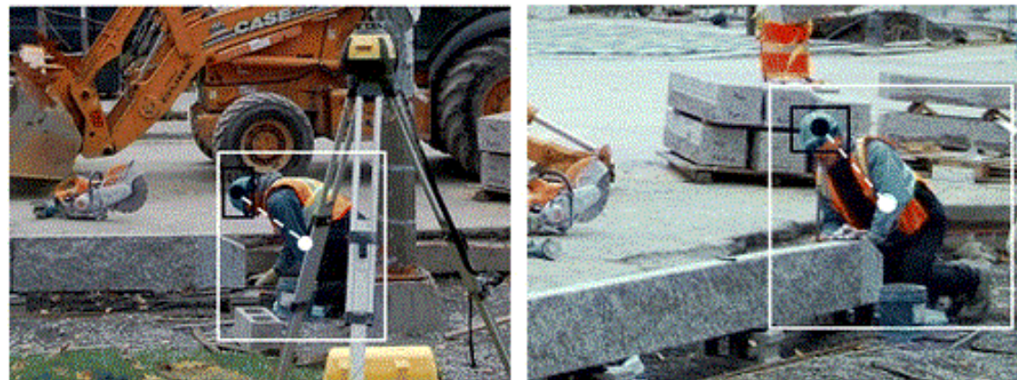
安全帽佩戴檢測可增強建築工人的現場安全
