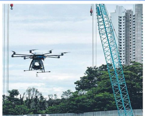
UAV工區安全巡檢
